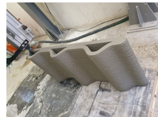
Tisk stěnového segmentu Printing of the wall segment
