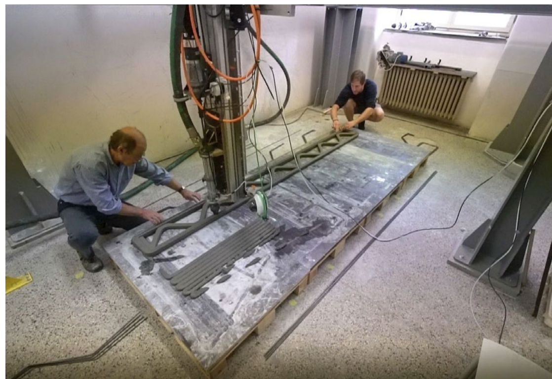
Manuelní vkládání výztuže do příhradového stropního prvku při tisku Manual insertion of the reinforcement into the truss floor element during printing
