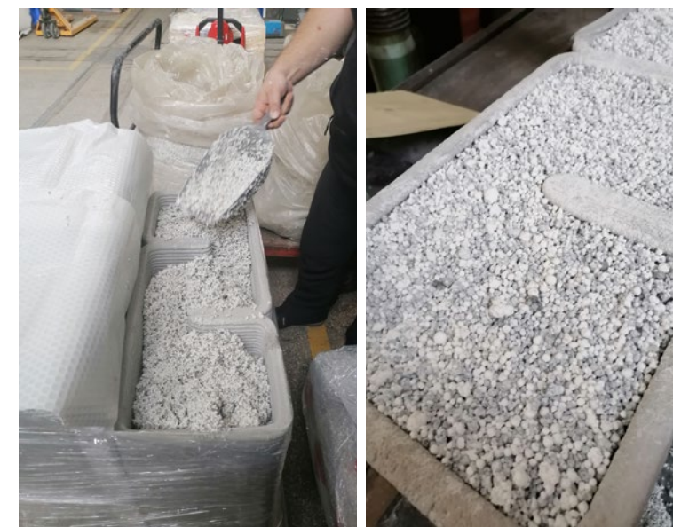
Aplikace tepelné izolace Thermowhite do segmentu vytvořeného 3D tiskem Application of Thermowhite thermal insulation to a segment created by 3D printing
