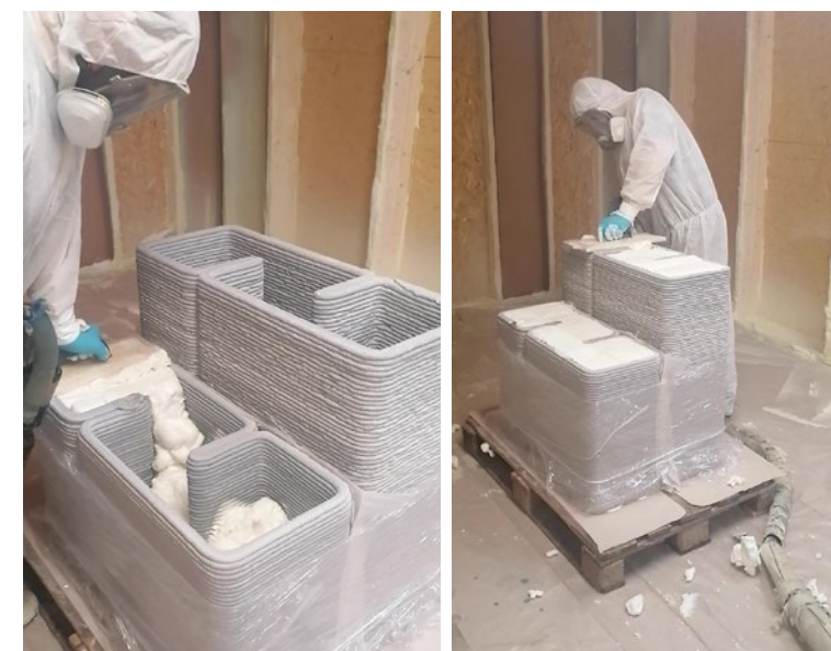
Aplikace stříkané pěny Icynene do dutiny segmentu stěnové obvodové konstrukce Application of Icynene spray foam in the cavity of a segment of the perimeter wall structure
