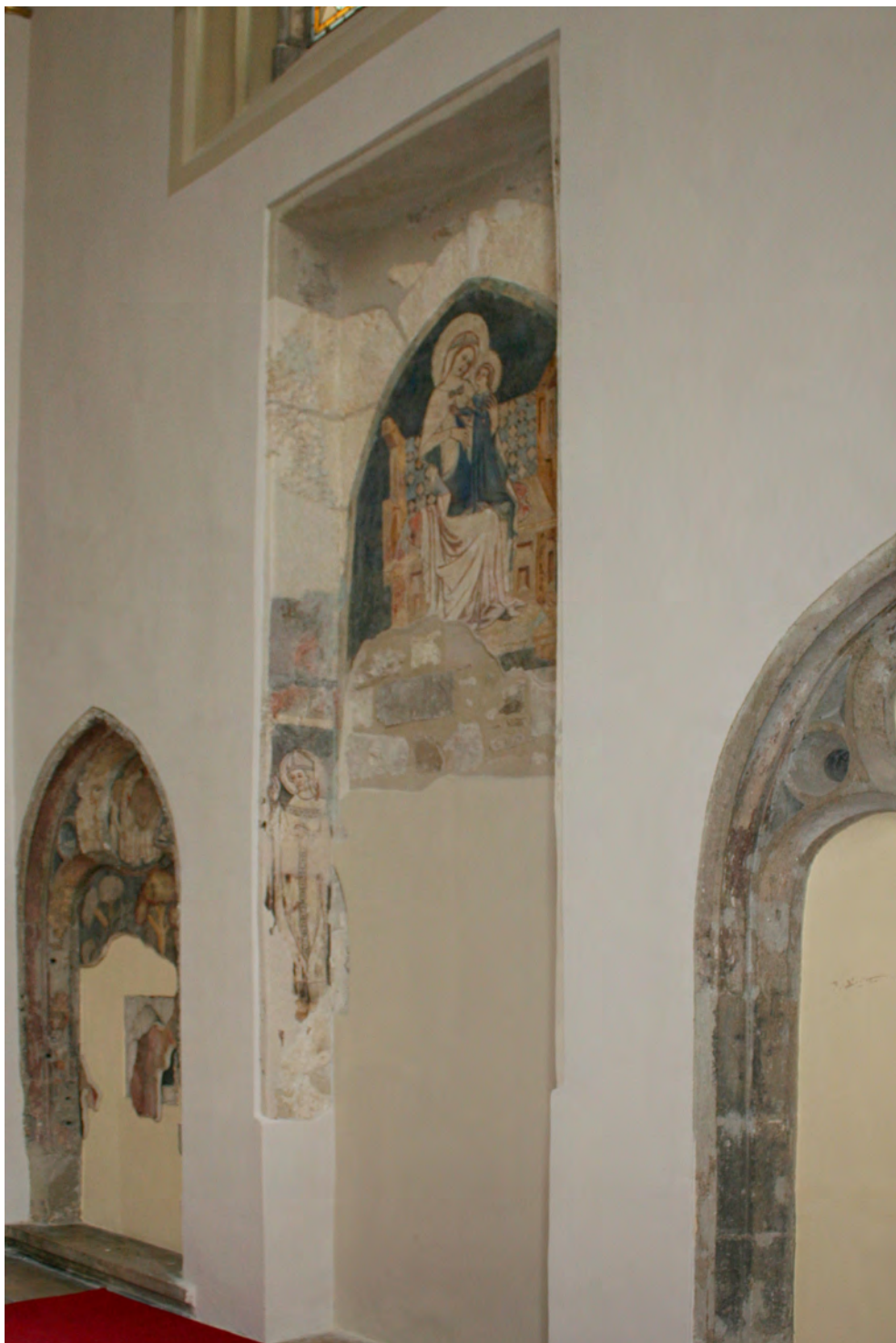
[2] Nástěnné výklenky v ambulatoriu farního kostela Vnitřního města. Foto: autor
