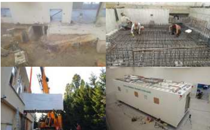
Zpevnění konstrukce budovy, stěhování a usazování komor. Bylo nutné koordinovat dva jeřáby a postupně závěsy přesouvat.
