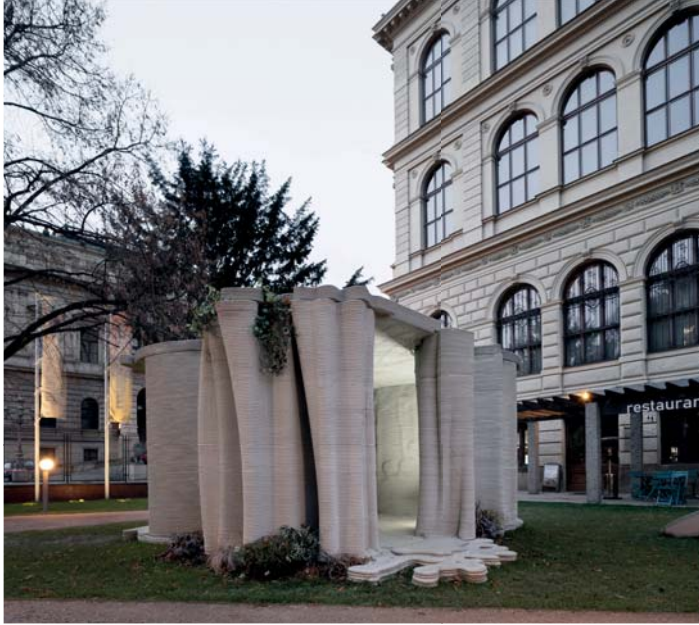
OBR. 1 Jiří Uran Vítek, Between Conflicts , pavilion v zahradě Uměleckoprůmyslového muzea v Praze, 2022, tištěná architektura
