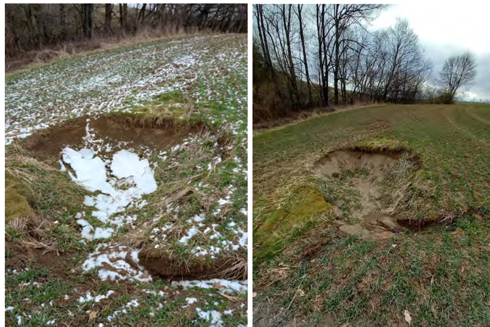
Obrázek č. 67: Kaverna vzniklá v souvislosti s nefunkční a poškozenou (propadlou) drenáží, vlevo leden 2022, vpravo únor 2022
