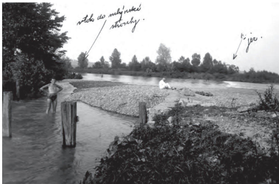
Obrázek č. 40: Vtok do mlýnské strouhy zanesený štěrkem po povodni z roku 1925
