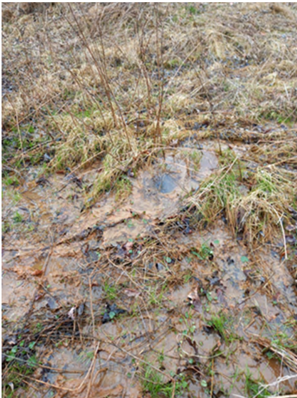
Vývěr vody z drenáže v údolnici v blízkosti zamokřeného pozemku Újezda
