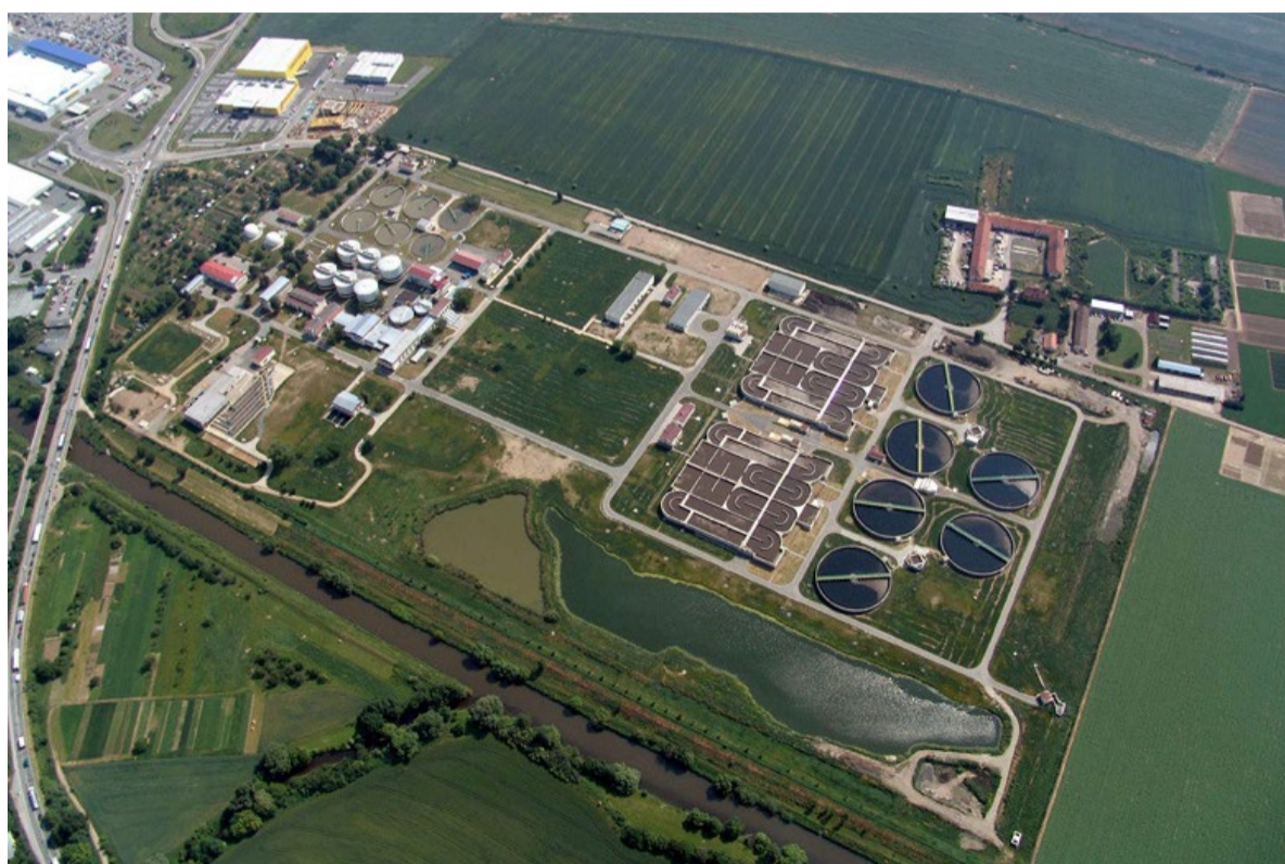
Čistírna Brno – Modřice
