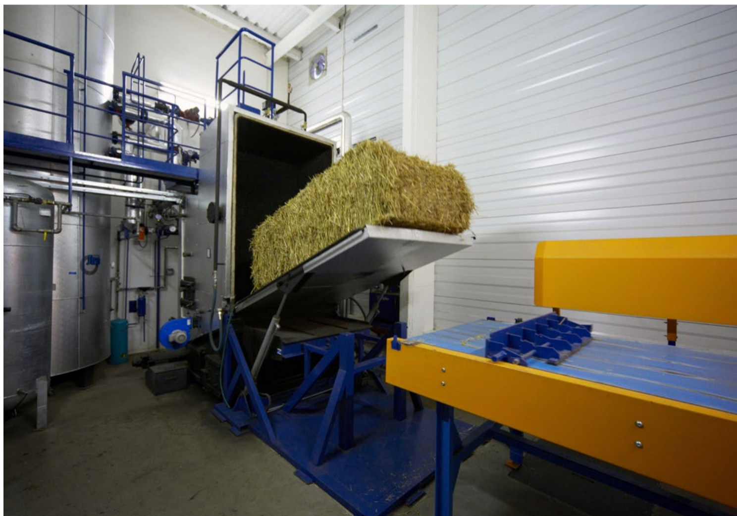
Kotelny na biomasu
