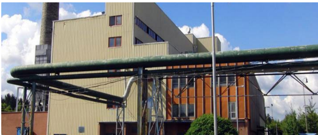
Výtopna CZT Mimoň
