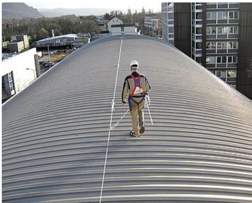
Horizontální jištění v praxi
