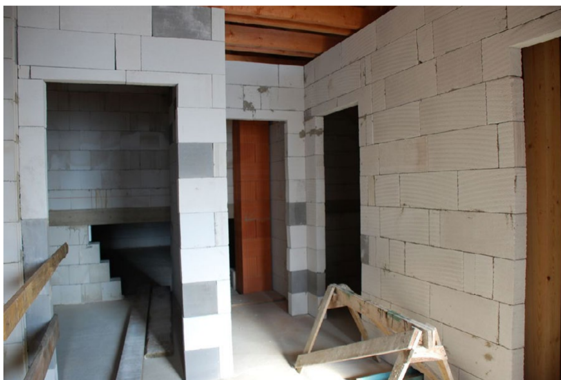
Svislé nenosné konstrukce – příčky (YTONG)
