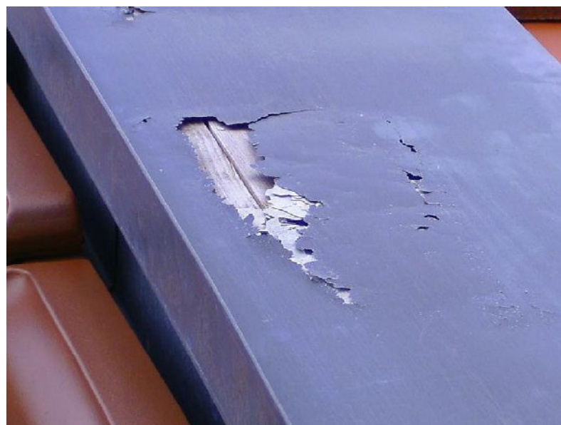
Bitumenová koroze
