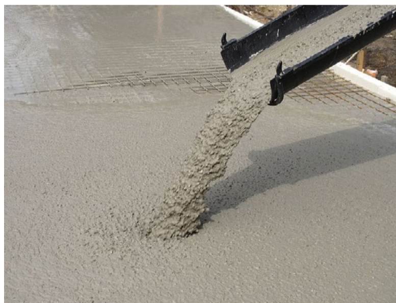
Výška pádu betonové směsi
