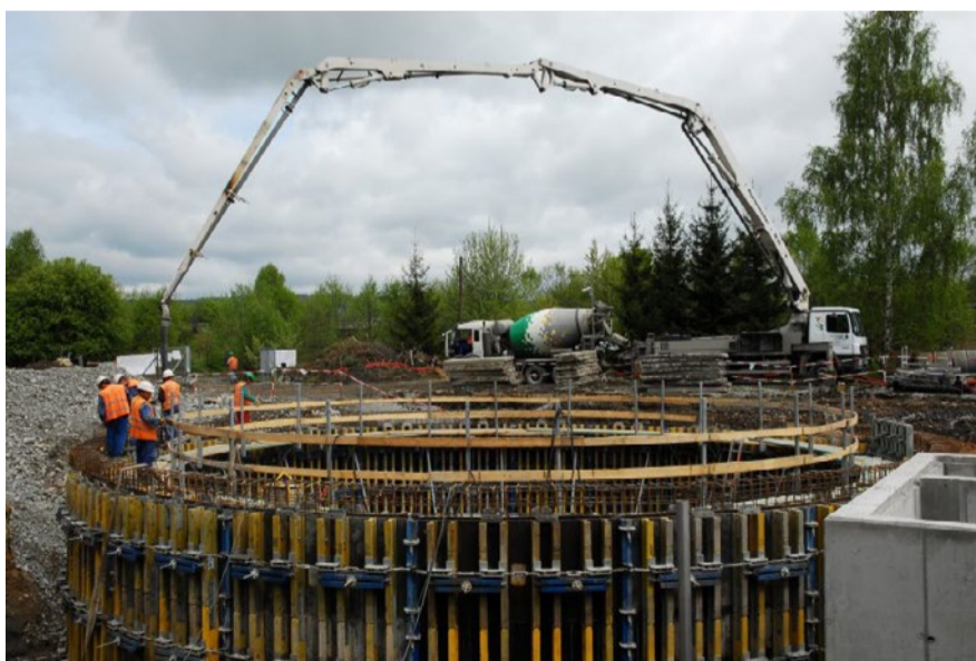
Čerpání betonu
