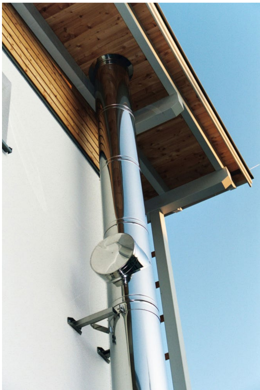
KeraStar – keramická vložka, kovový plášť
