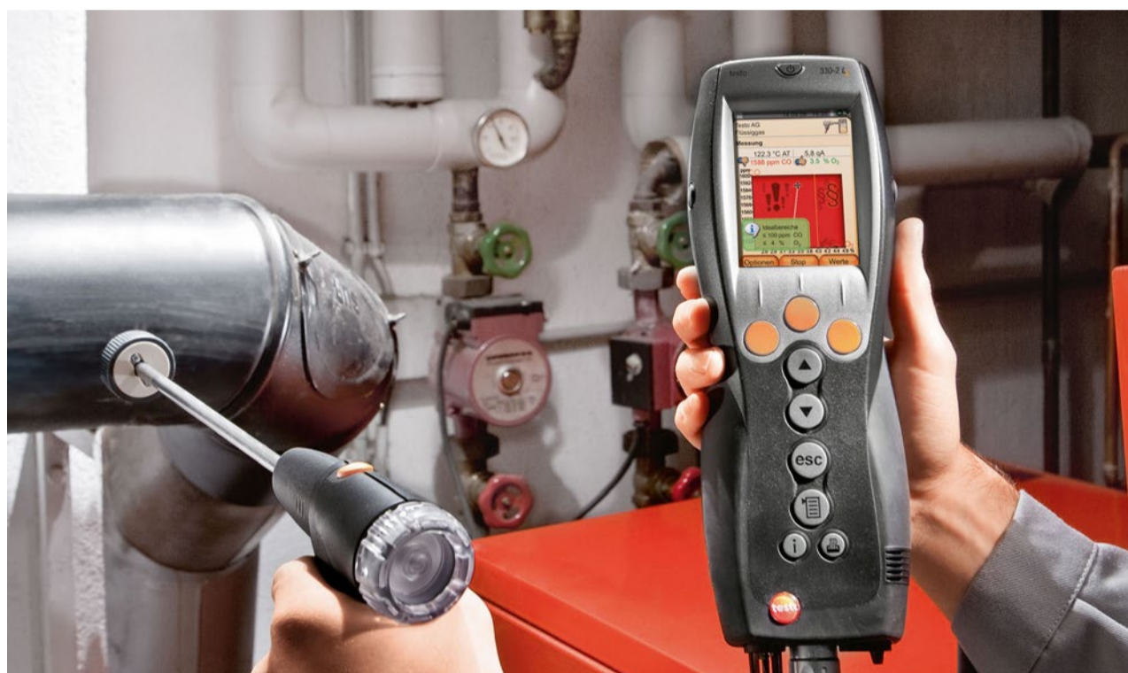
Způsob vložení sondy do měřicího otvoru na kouřovodu
