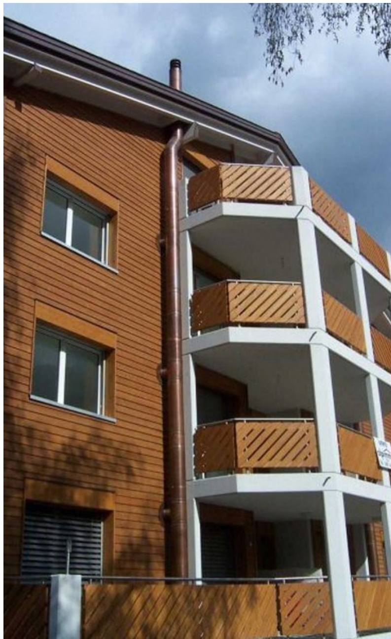
Dodatečná stavba komínu pomocí nerezových systémů
