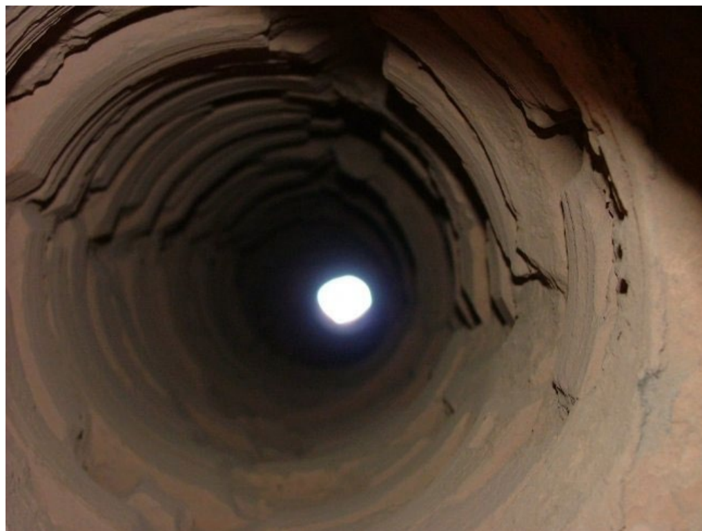
Komínový průduch po vyfrézování
