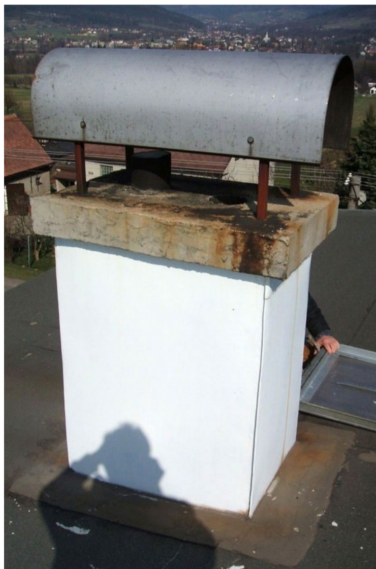
Pohled na starší komínovou hlavu
