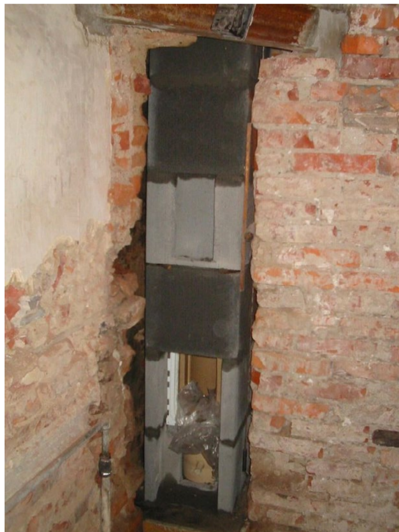
Dodatečná vestavba komínu bývá náročná na stavební úpravy
