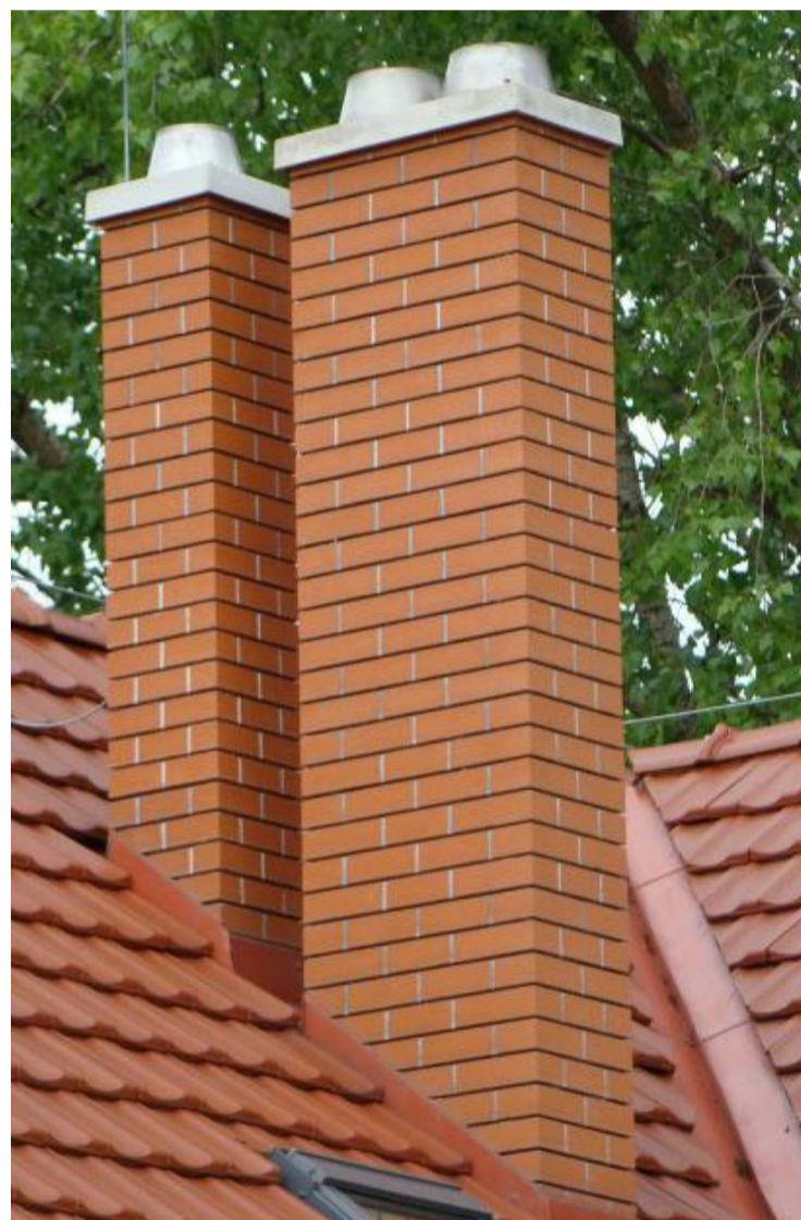
Nová úprava komínové hlavy
