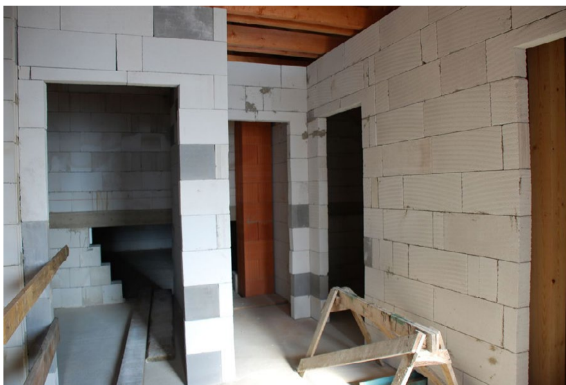
Svislé nenosné konstrukce – příčky (YTONG)
