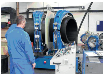
Obr. 9.5 Zařízení pro svařování trubek velkých průměrů na tupo
