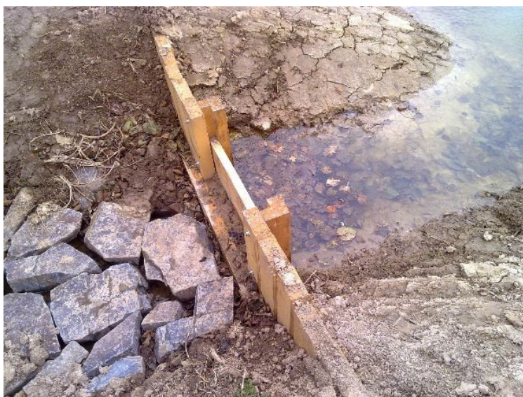
Obr. 3 Dřevěná štětovnicová přehrážka – příklad řešení – foto: Karel Zlatuška
