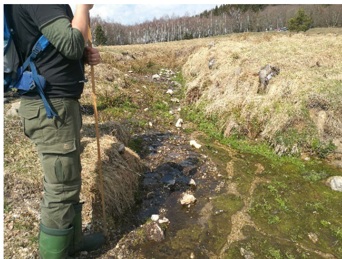
Obr. 8 Odvodněné prameniště – stav před realizací.
