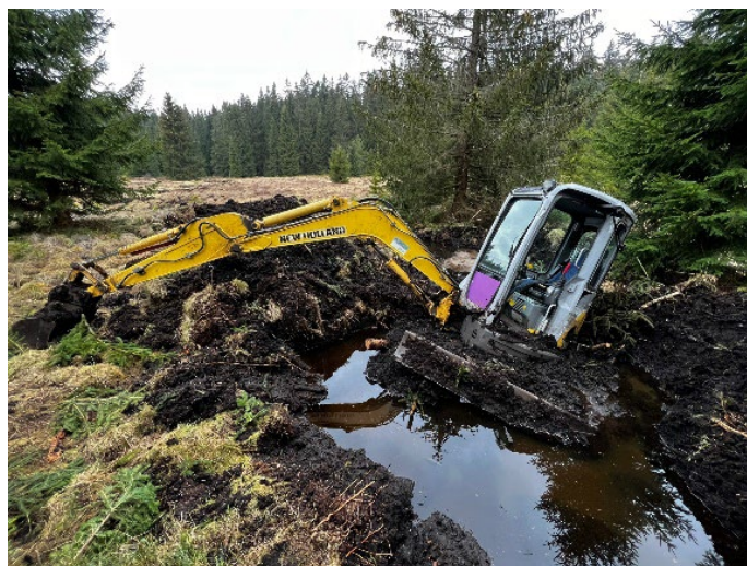
Obr. 10 Úskalí realizace stavby v rašeliništích.
