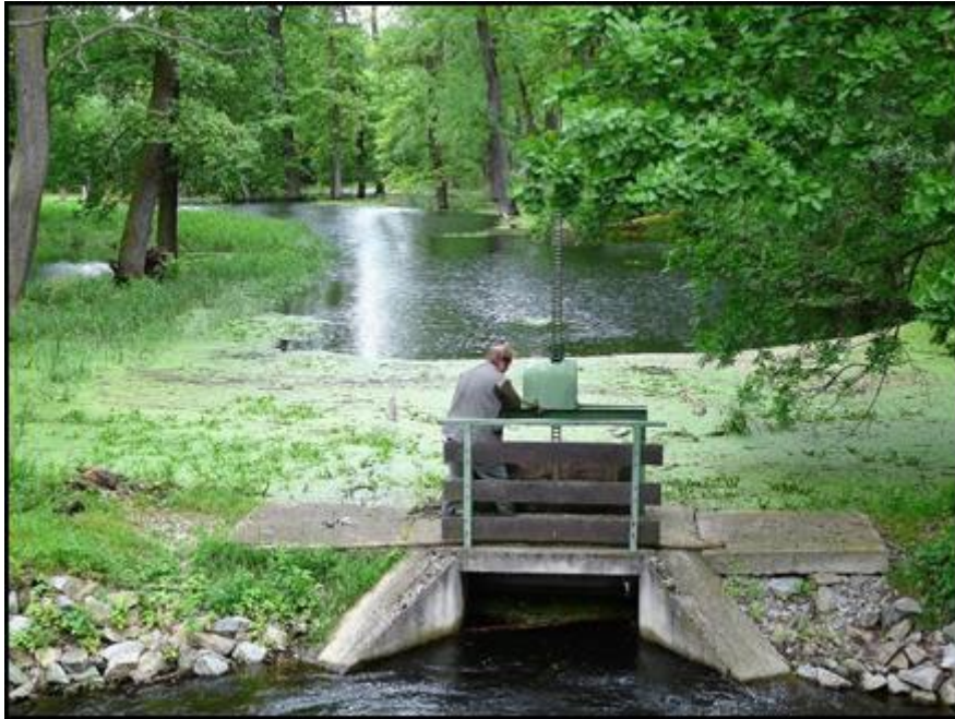
Obr. 3 Stavidlový objekt zbudovaný na revitalizační soustavě vodních kanálů v 90. letech na polesí Soutok.
