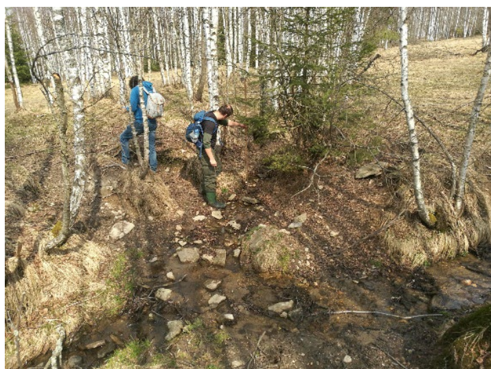
Obr. 6 Ověřování parametrů odvodňovacích kanálů.
