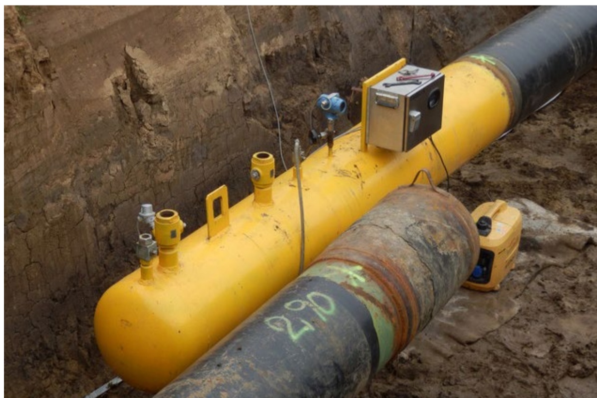
Tlakové zkoušky plynovodu (tlakovací komora včetně měření)
