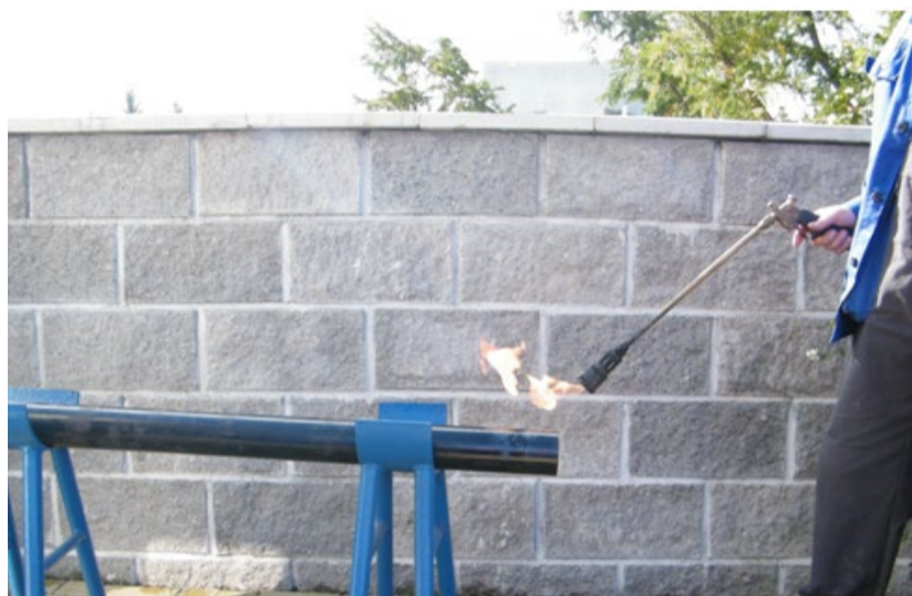
1. Nahřívání konce trubky hořákem PB pro snadnější odizolování
