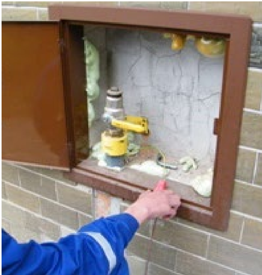
Připojení konektoru vyhledávače na signalizační vodič PE přípojky
