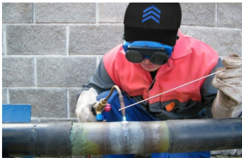
3. Spojení trubek svařováním
