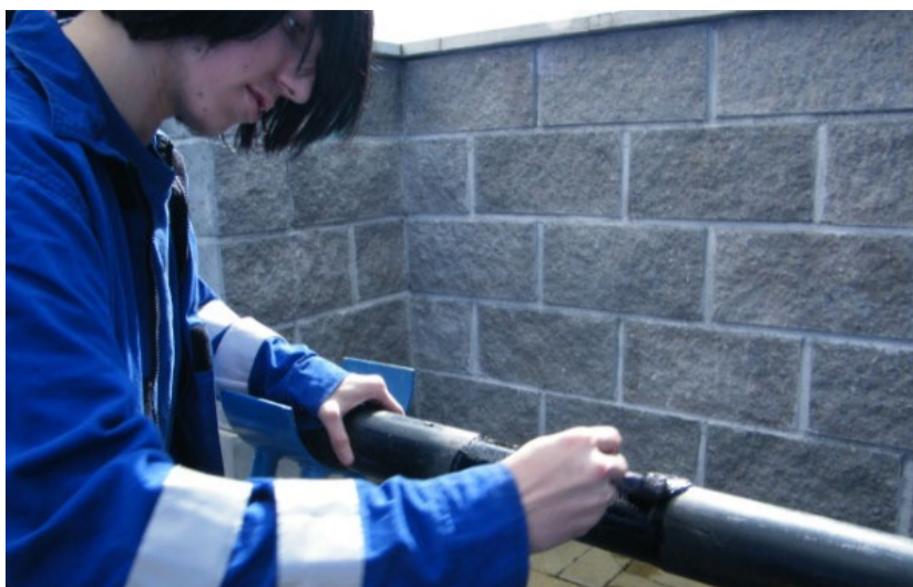
7. Natření potrubí asfaltovým lakem
