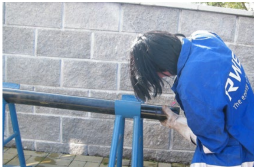
2. Odstranění izolace na konci trubky nožem, přibližně 150 mm
