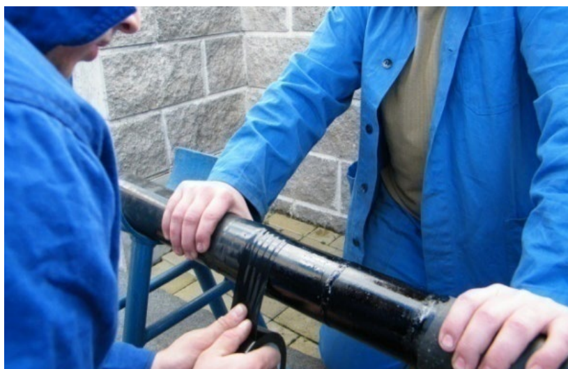
8. Izolace dle návodu výrobce izolačních pásek
