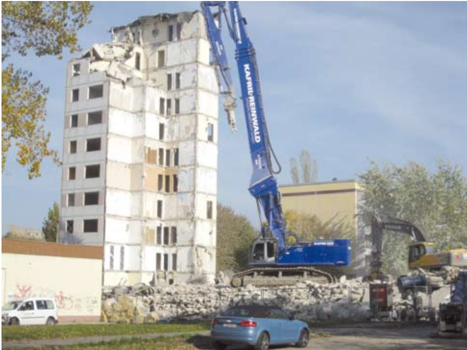
Obrázek 1 Bourání prázdných panelových domů v Halle Neustadtu 10
