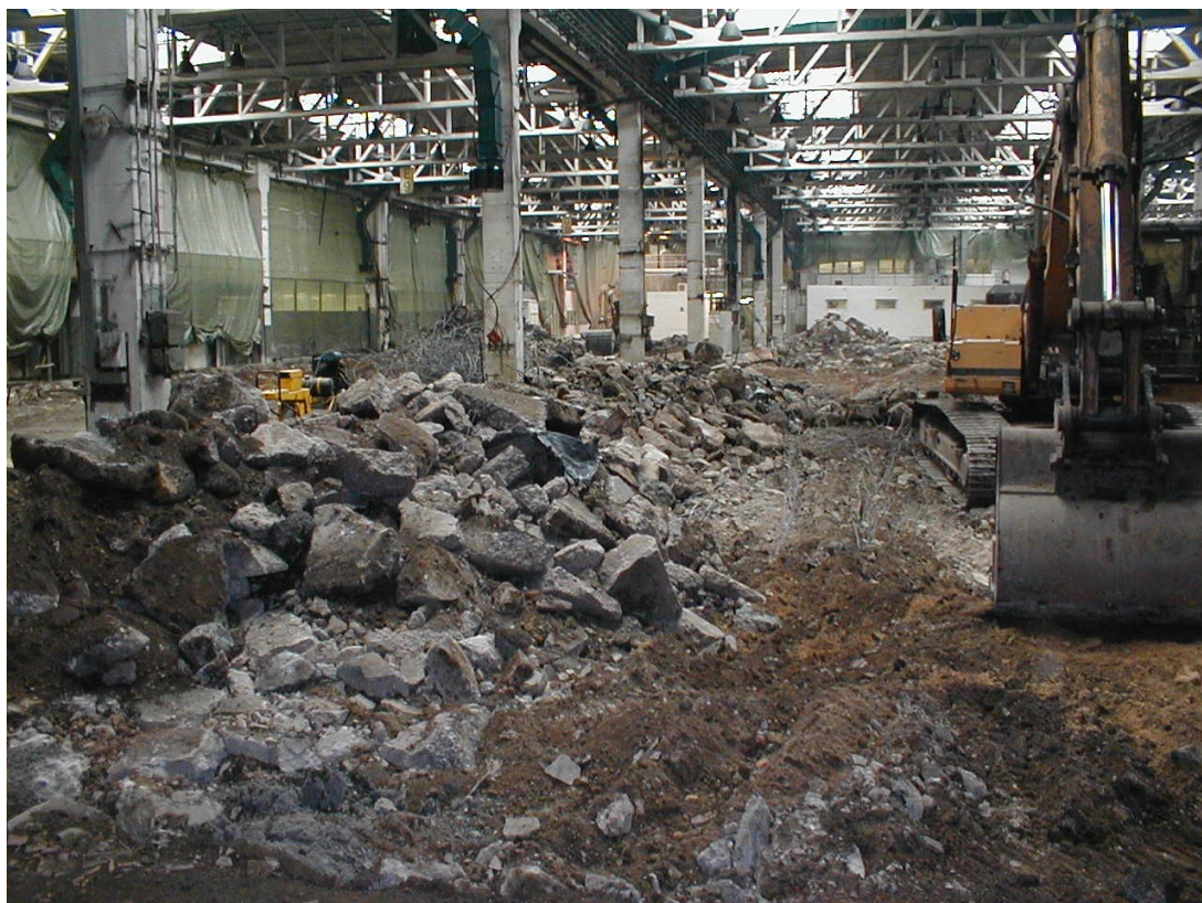
Obrázek 1: Hala M1 vybourané kontaminované materiály, zdroj: Václav Tima (ŠKODA AUTO a. s.).
