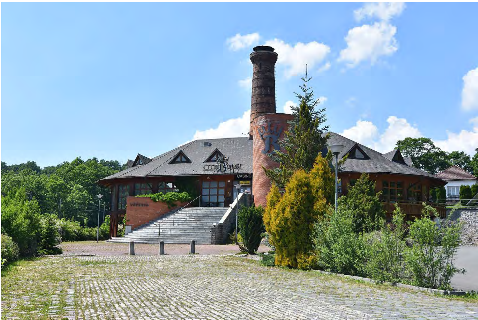
Obrázek č. 33: Technická památka vápenky v Černotíně jako součást historického využívání krajiny
