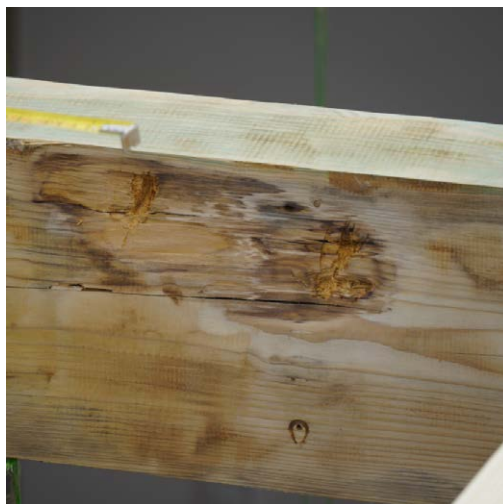
Obr. 82: Postupné otváranie strechy a realizácia nového záklopu ako podkladu pre novú skladbu strešného plášťa. Pôvodné stropnice boli dodatočne ohobľované pre odstránenie poškodených a napadnutých povrchov. Vpravo detail hniloby stropnice, ktorá zasiahla drevo do väčšej hĺbky.
