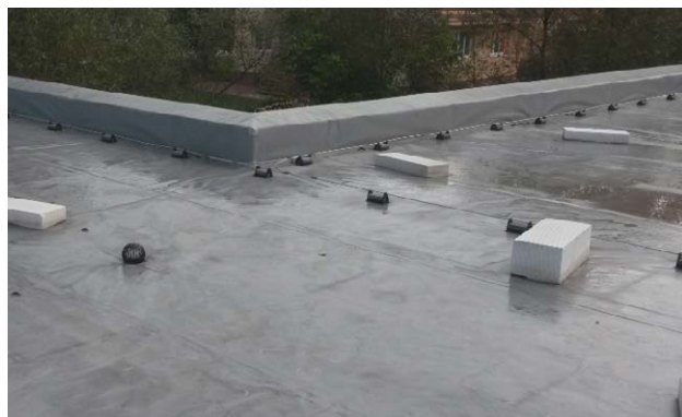
Obr. 67: Strecha pri realizácii zátopovej skúšky. Vpravo spodný záklop pred realizáciou zaveseného SDK podhľadu
