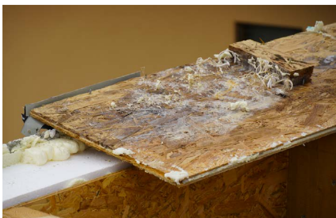
Obr. 83: Výrazná degradácia OSB dosiek a drevených hranolov zasiahla aj atiku, ktorá bola z nich vytvorená a podkladnú dosku pod oplechovanie atiky (doska je už otočená, jedná sa o jej pôvodne spodnú stranu)
