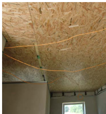
Obr. 67: Strecha pri realizácii zátopovej skúšky. Vpravo spodný záklop pred realizáciou zaveseného SDK podhľadu
