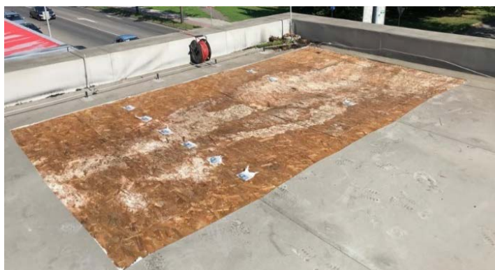
Obr. 66: OSB doska ako podklad pod povlakovú krytinu a jej degradácia spôsobená tvorbou kondenzátu a orosovaním pod mPVC fóliou (foto P. Krajčovič)
