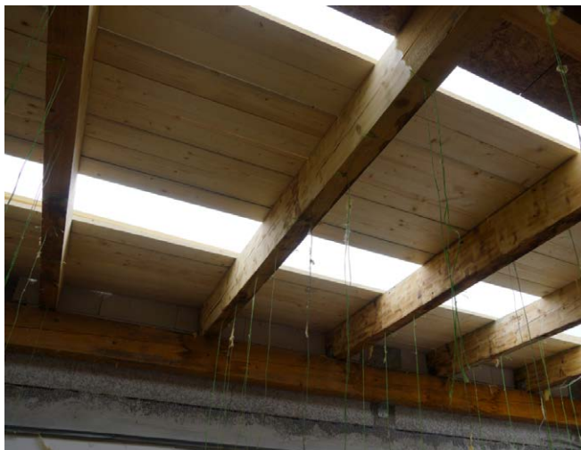
Obr. 82: Postupné otváranie strechy a realizácia nového záklopu ako podkladu pre novú skladbu strešného plášťa. Pôvodné stropnice boli dodatočne ohobľované pre odstránenie poškodených a napadnutých povrchov. Vpravo detail hniloby stropnice, ktorá zasiahla drevo do väčšej hĺbky.
