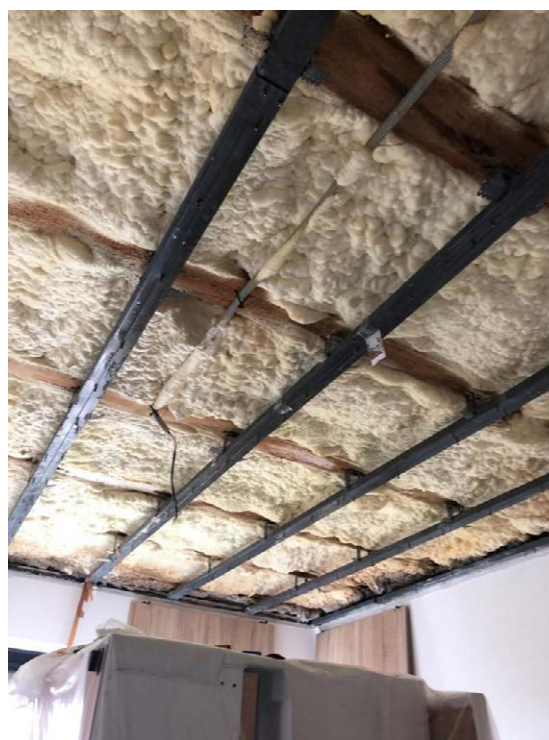
Obr. 64: Striekaná polyuretánová pena medzi stropnicami a nosná konštrukcia SDK podhľadu po demontáži (foto P. Krajčovič)
