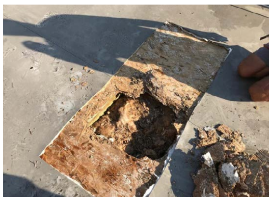
Obr. 66: OSB doska ako podklad pod povlakovú krytinu a jej degradácia spôsobená tvorbou kondenzátu a orosovaním pod mPVC fóliou (foto P. Krajčovič)
