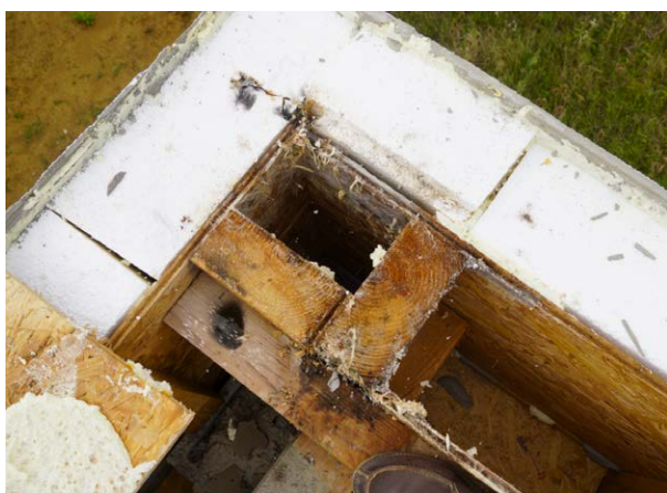
Obr. 83: Výrazná degradácia OSB dosiek a drevených hranolov zasiahla aj atiku, ktorá bola z nich vytvorená a podkladnú dosku pod oplechovanie atiky (doska je už otočená, jedná sa o jej pôvodne spodnú stranu)
