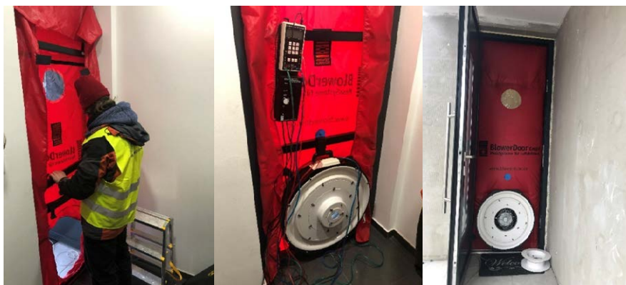
Obr. 123: Osadenie ventilátora do vstupných dverí rodinného domu
