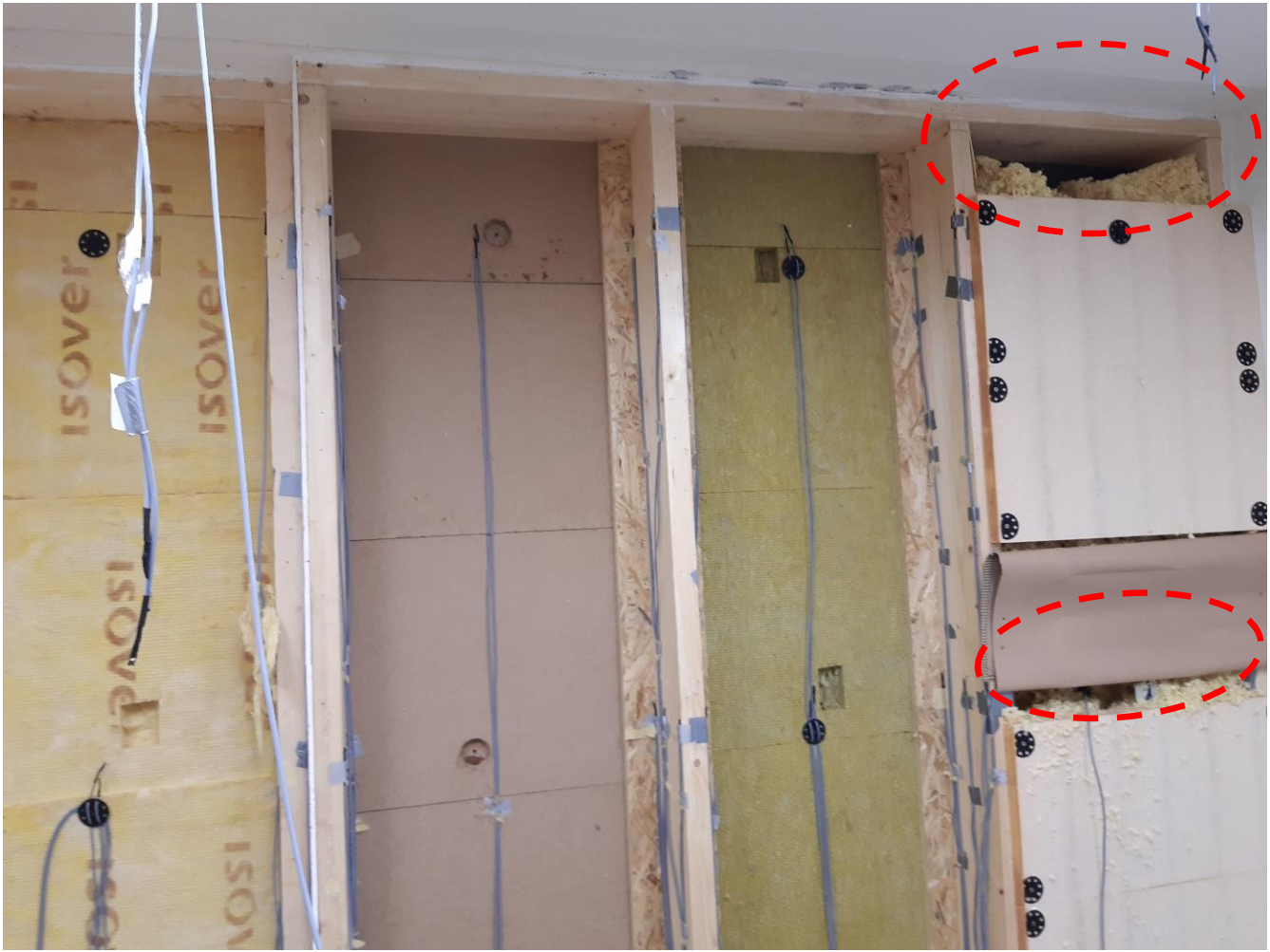
Obr. 119: Skladba V5 s objavenými vzduchovými dutinami
