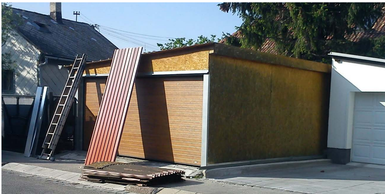
Obr. 62: Príklad použitia OSB dosky v exteriéri s viditeľným účinkom vetrom hnaného dažďa zo západnej strany a počiatočnou degradáciou
