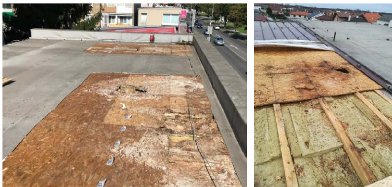
Obr. 60: Použitie OSB dosky ako podklad pod povlakovú krytinu a jej degradácia spôsobená kondenzáciou na spodnom povrchu [1]
