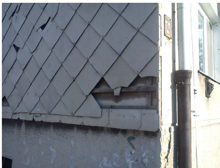
Obr. 99: Azbestocementové šablóny na drevenom rošte ako ochrana náveternej strany fasády proti vetrom hnanému dažďu
