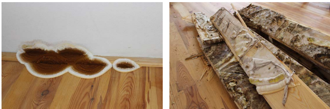
Obr. 31: Plodnice dřevomorky domácí (vlevo) a povrchové mycelium ze spodní strany podlahových prken (vpravo)
