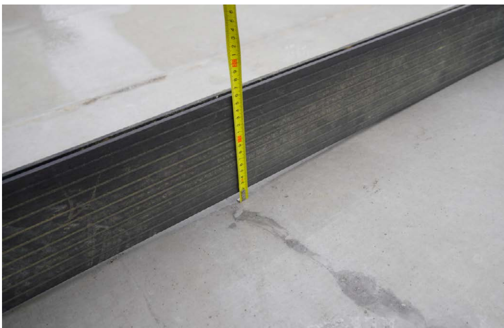
Obr. 80: Trvalý priehyb degradovanej OSB dosky hr. 15 mm bol nameraný max. cca 20 mm. Vďaka tomu bolo zrejmé, kde sú stropnice a znížilo sa riziko prepadnutia počas pohybu po streche.
