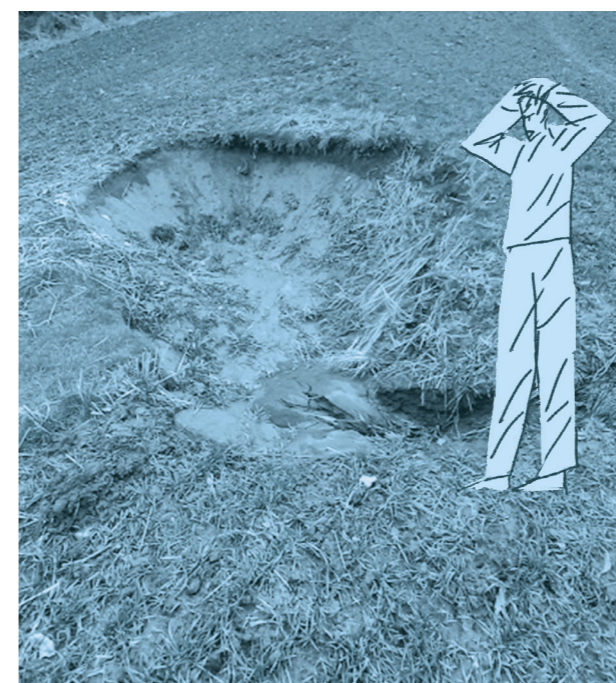
Propadlá kaverna na poli nedaleko Kobylanek. Kaverna je podzemní dutina, jež vzniká odnosem půdy v okolí drenáží. Zobrazená kaverna je hluboká až 1,5 metru a v průměru má téměř 2 metry. Do této kaverny spadne i traktor.
